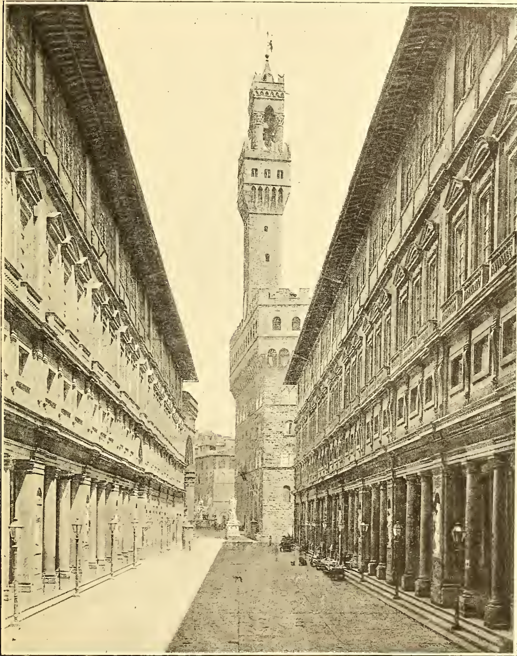
Le Palais des Offices à Florence, par Vasari.
